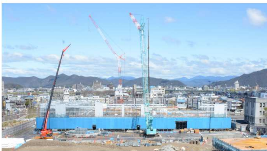
みんなの森 「ぎふメディアコスモス」の工事状況（H26.3）
